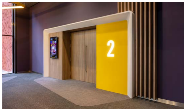
Les numéros des salles incrustés, sont éclairés par l'arrière pour faciliter l'orientation de manière discrète.
