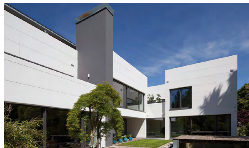
Architetto: Dipl.-Ing. Volker Wiese, Berlin - Kaden Klingbeil Architekten | Realizzazione: Kiebitzberg GmbH & Co.KG - Klopfer Surfaces | Foto: Dirk Wilhelmy
