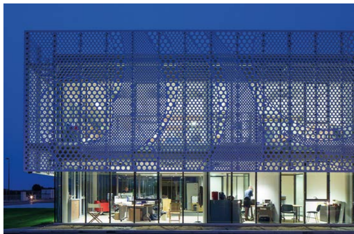
Design: PAD Architectes for BERI 21 | Realizzazione: LCCA | Foto: Mathieu Ducros
