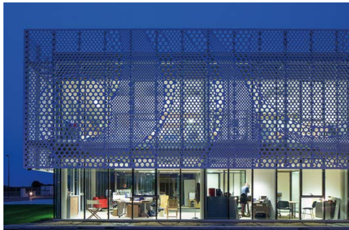
Création : PAD Architectes for BERI 21 | Fabrication : LCCA | Photo : Mathieu Ducros
