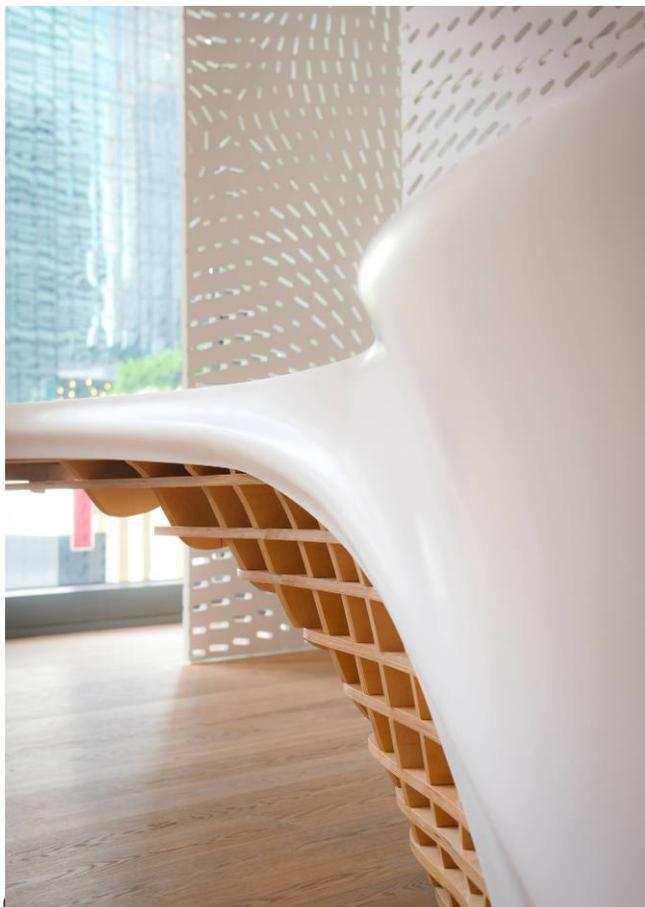
Une bande d'1,5 m de large (en plusieurs morceaux) a été produite pour suivre la courbe du plateau. Cette bande a été utilisée comme une courroie de secours là où le flanc de la table rencontre la face cachée du plateau. Cette courroie a été collée sur place, avec des ondulations réalisées dans son profil pour aider l'atelier à aligner les flancs plus tard dans le processus.
