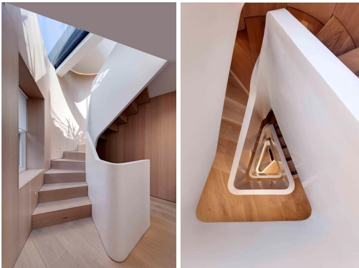
La rampe, fabriquée en pierre acrylique **HI-MACS®** dans la couleur Alpine White donne une cohérence et une fluidité de mouvement à l'ensemble. Elle s'élève tel un ruban qui s'enroule et se déroule d'étage en étage offrant une vue vertigineuse de 14 mètres du toit en verre jusqu'au sous-sol. L'effet tridimensionnel de cette « spirale triangulaire » a été réalisable grâce aux propriétés thermoformables du matériau, qui permettent de concevoir toutes sortes de formes sans jointures,
